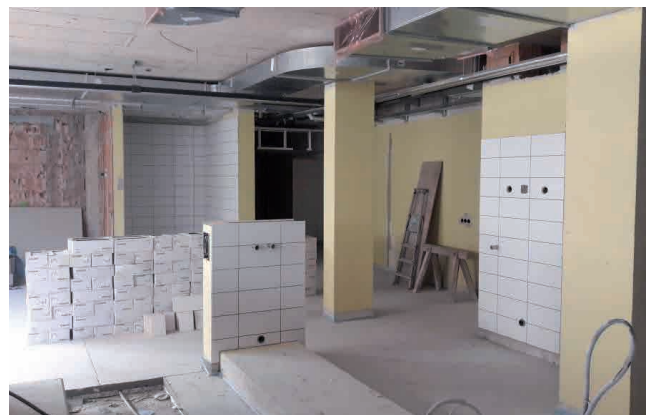
Großbaustelle im Keller: Der Keller des Seniorenwohn- und Pflegeheims in Simbach am Inn wurde bei der Flutkatastrophe 2016 komplett überflutet und musste entkernt & saniert werden.
